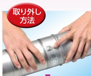
二重管の受口側のストッパーピースを引いた状態 (抜け防止機構を解除) で二重管をまっすぐ引き抜いてください。
